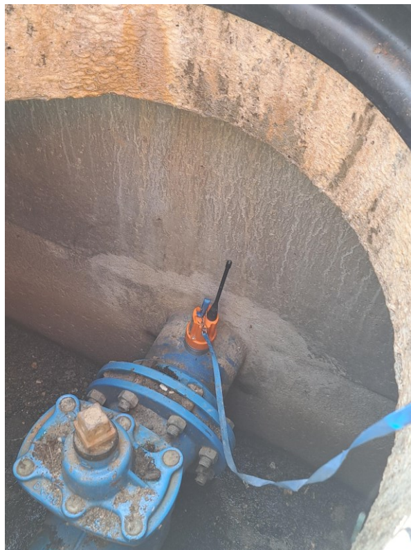
Prélocalisateur à poste fixe installé dans un regard
