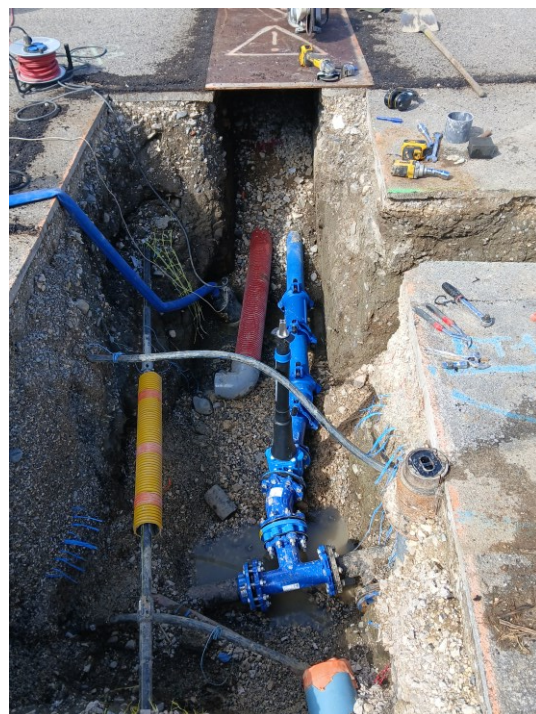
Extension du réseau route du Stade (Sillingy)
