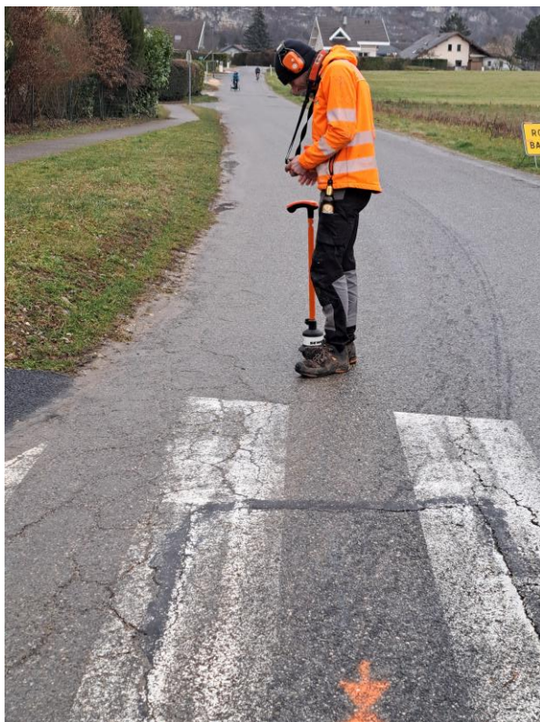
Un agent du Service en pleine recherche de fuite
