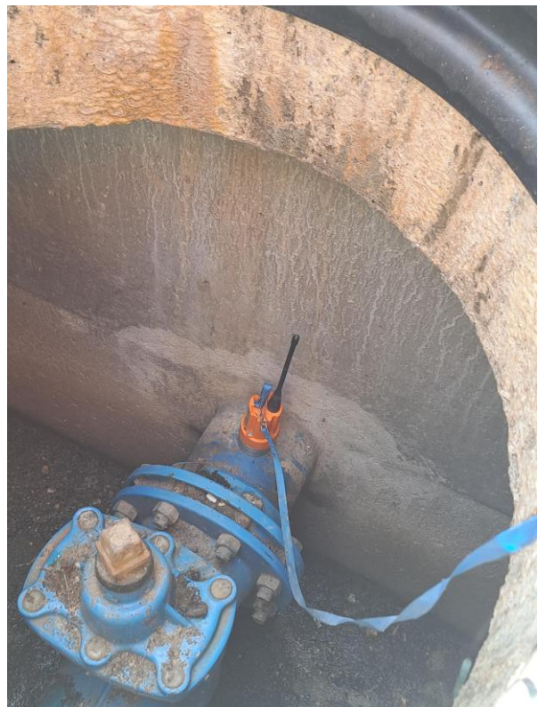
Prélocalisateur à poste fixe installé dans un regard
