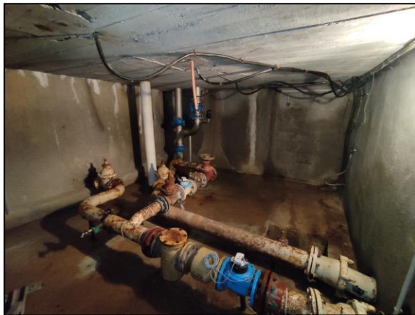
Chambre de vannes et pompes au réservoir de Sapins Avant travaux
