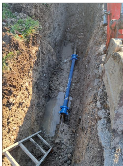
Fuite réparée sur le réseau de Champfleury, à Choisy
